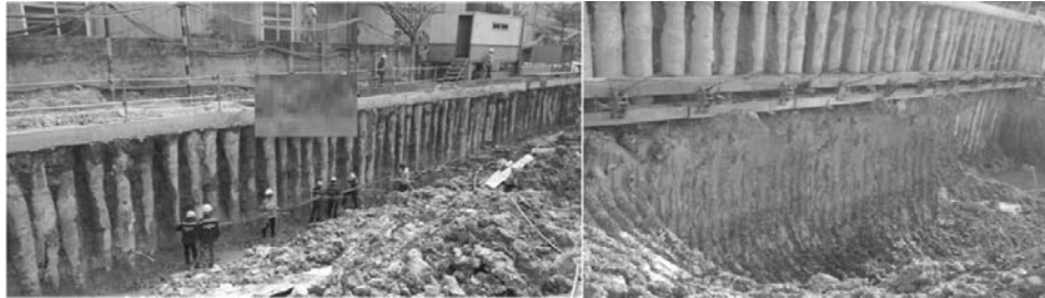
Hình 1: Tường cọc nhồi liên tục trong thi công hố đào sâu (Goldmark city)
