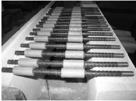
a- Chuẩn bị cốt thép
